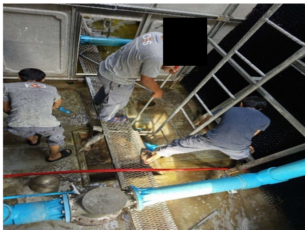
ภาพถ่ายที่ 2-16 การทำความสะอาดท่อฝังเย็น
