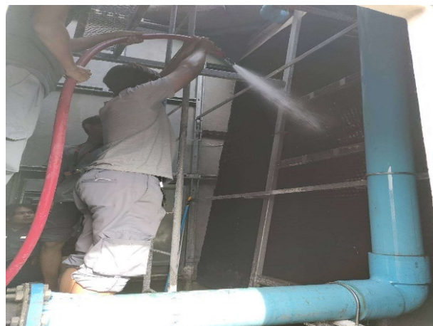
ภาพถ่ายที่ 2-16 การทำความสะอาดท่อฝังเย็น
