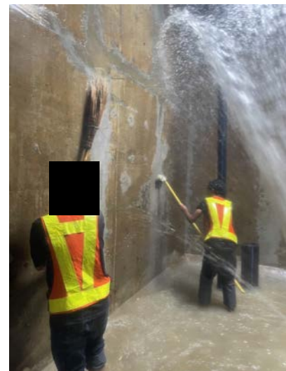
ภาพถ่ายที่ 2-9 การล้างถังเก็บน้ำของโครงการ
