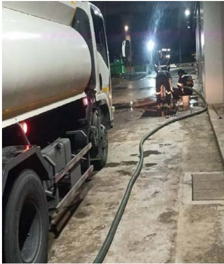
ภาพถ่ายที่ 2-5 จัดเก็บตะกอนส่วนเกินของระบบบำบัดน้ำเสีย
